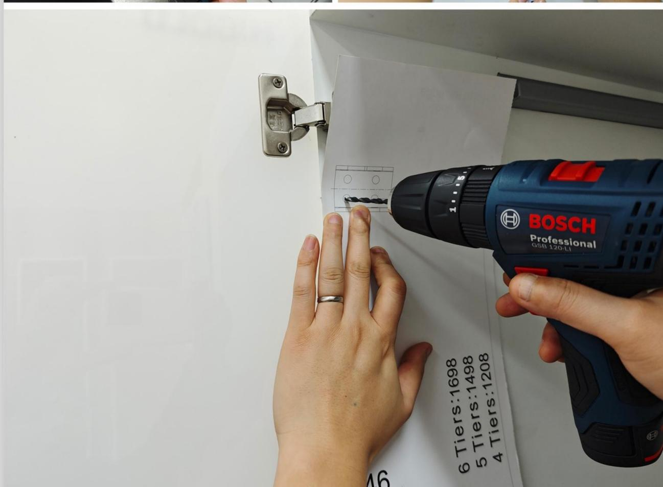
使用安装模版对门板框架下转动底座预钻孔，再以柜底面为基准，1698mm处柜边画一个基准点，安装模版下孔对准基准点，进行上转动底座预钻孔。
