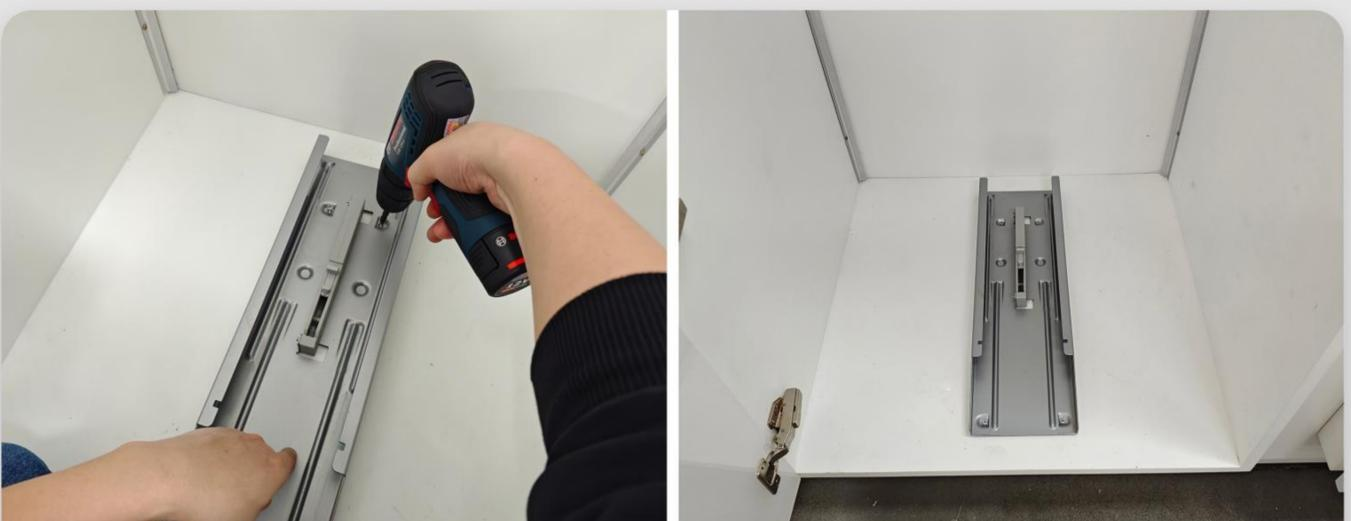
大导轨外轨对准预钻孔，锁紧自攻螺丝。
