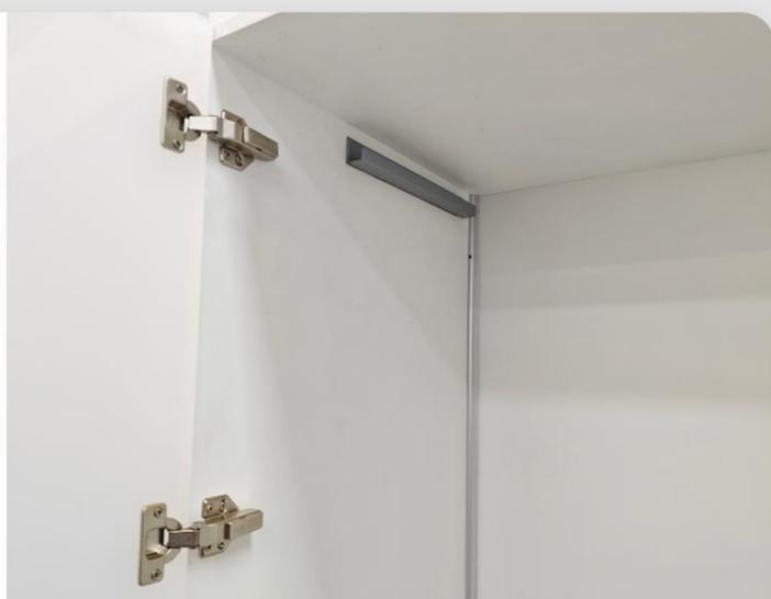
上滑槽按两条基准线交点定位，预钻孔后，擦除画线痕迹，再使用自攻螺钉锁紧。
