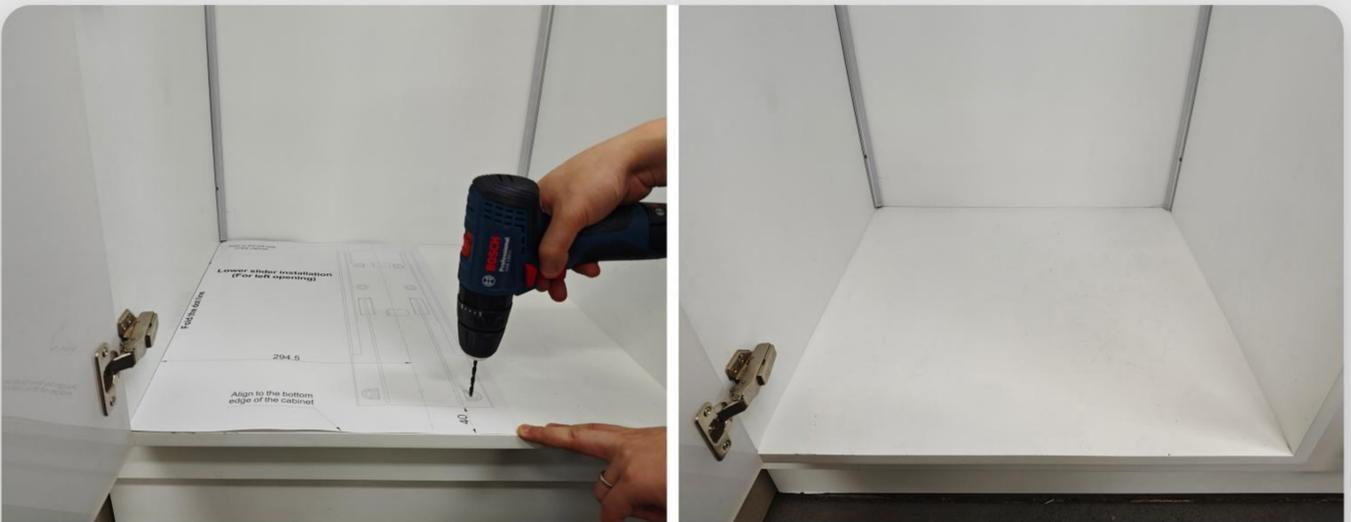
使用左开安装模板，对齐柜边，预钻孔。
