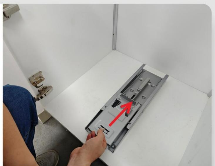
调整大导轨外轨阻尼，使其处于打开状态，再将内轨滑轮对准外轨推入，使外轨阻尼挂钩挂入内轨。
