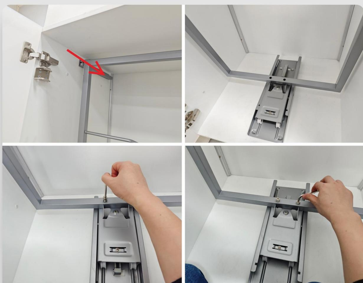
主框架左上滑轮放入上导槽，底部对准大导轨内轨凹槽处，框架底部用两颗螺丝锁紧。
