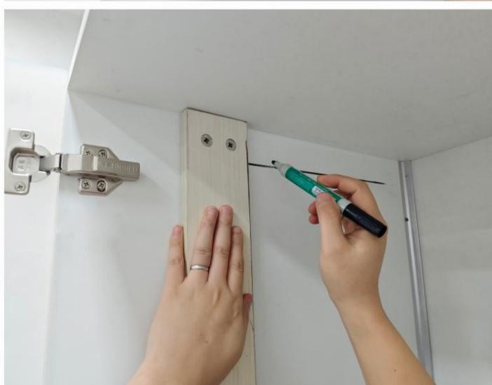
以柜底面基准，按模板要求，1792mm处画一条水平基准线，再以柜边为基准，200mm处画第二条竖直基准线。
