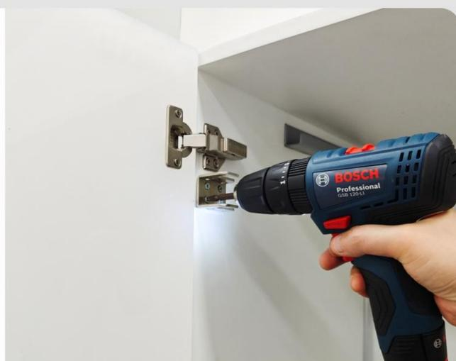
对准预钻孔使用自攻螺钉锁紧门板框架转动底座（下/上）。
