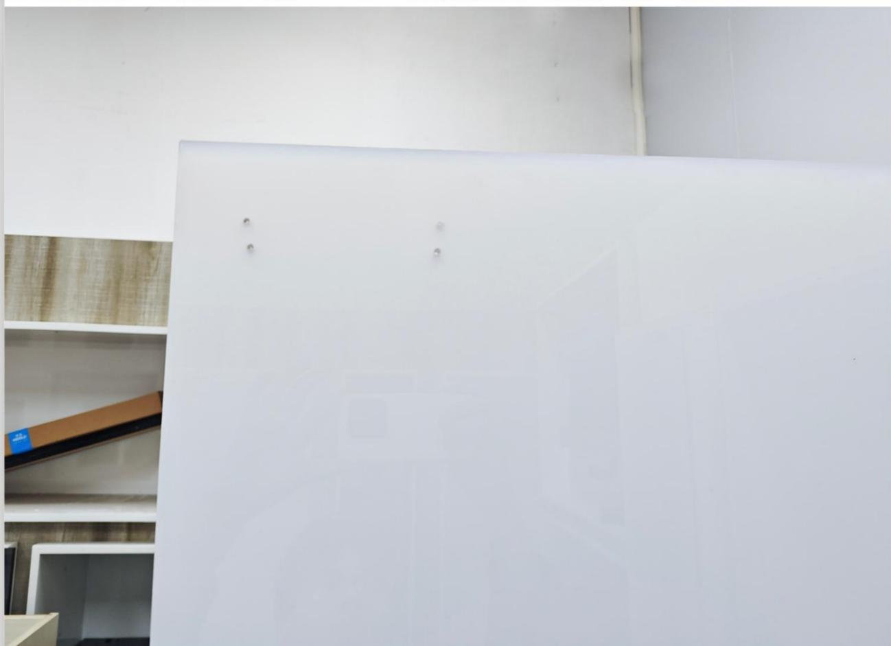
以柜门底边为基准，按1826mm在柜边画一个基准点，安装模版上孔对准基准点，按模板预钻孔。
